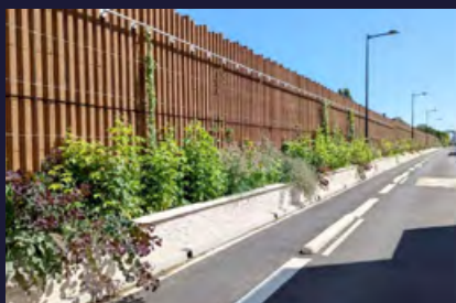
Écran anti-bruit construit le long du RER A à Fontenay-sous-Bois.
