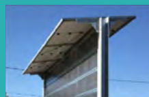
Couronnement photovoltaïque pour écran
