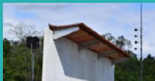
Écran bas proche des voies intégrant un diffracteur
